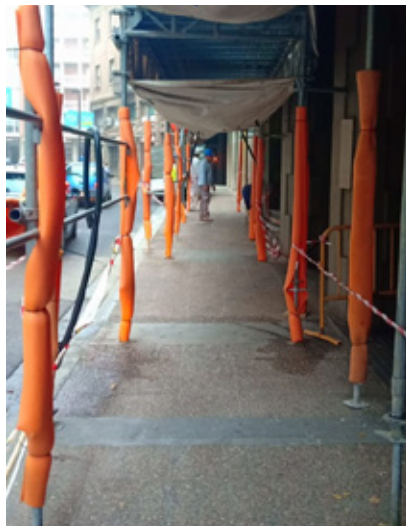
Pont de pas protecció vianants
